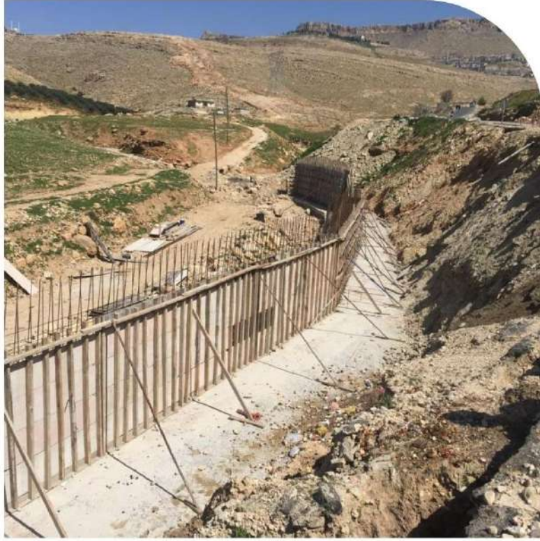
Artuklu-Kızıltepe-Derik-Savur ve Midyat İlçeleri Yol-Duvar ve Menfez Yapım İşi'ne 7.413.940,00-TL Harcama Yapılmıştır.
