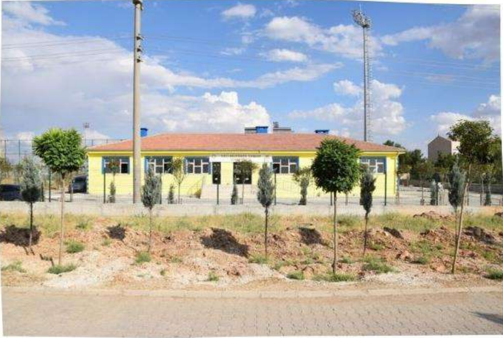
Mardin İli Artuklu İlçesi İstasyon Mahallesinde Bulunan Futbol Sahasına Sosyal Tesis Yapım İşi'ne 1.465.577,23-TL harcama yapılmıştır. (Şekil 1-2)
