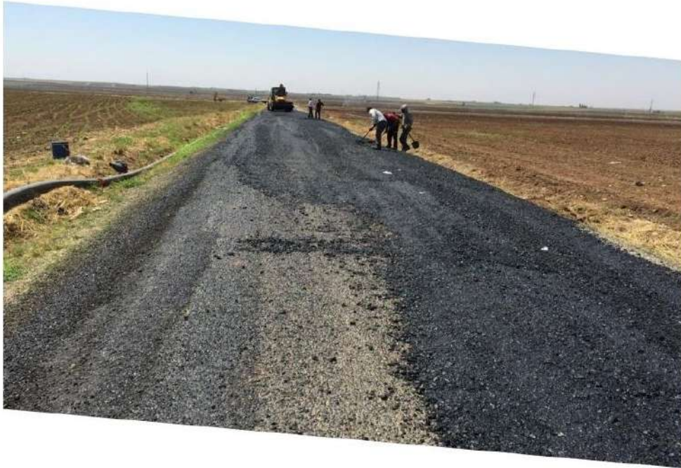
Kırsal Muhtelif Mahalle Yolları (Güvenlik Yolları) Asfalt Yama Yapım İşı 8.504.575,00- TL Harcama Yapılmıştır.
