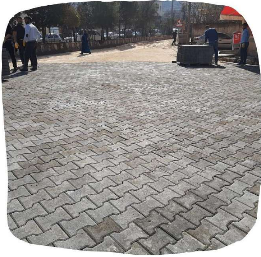
Mardin İli Muhtelif Mahalle Yolları Yapım ve Onarım İşı 8.651.378,00-TL Harcama Yapılmıştır.
