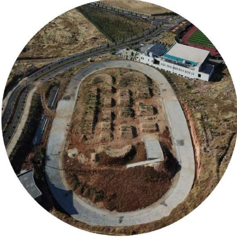
Mardin İli Artuklu İlçesi Veledrom (Profesyonel Bisiklet Parkuru) Yapım İşi'ne 4.338.766,40-TL harcama yapılmıştır (Artuklu Üniversitesi Yerleşkesinde Yapılmıştır)
